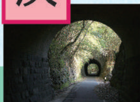
厚ヶ淵トンネル
