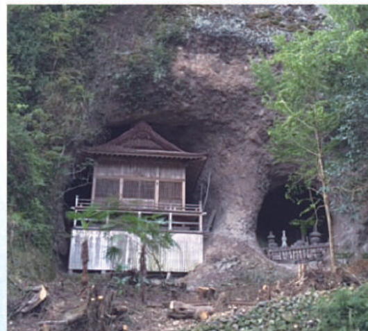
岩窟に建てられた久福寺観音堂
