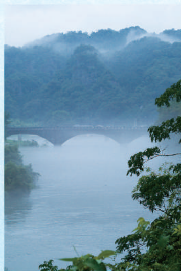
羅漢寺橋 長さ日本3位の県指定三連橋
