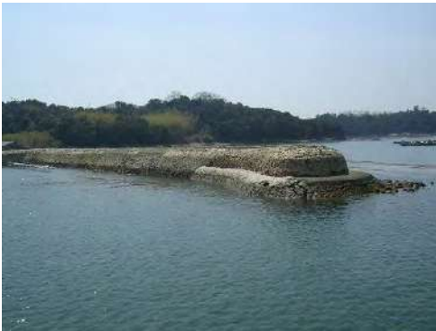
49-① 大多府漁港元禄防波堤
