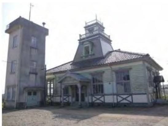
22-② 旧伏木側候所庁舎・測風塔
