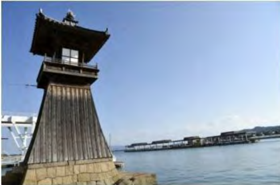
36-⑦ 旧野崎浜灯明台
