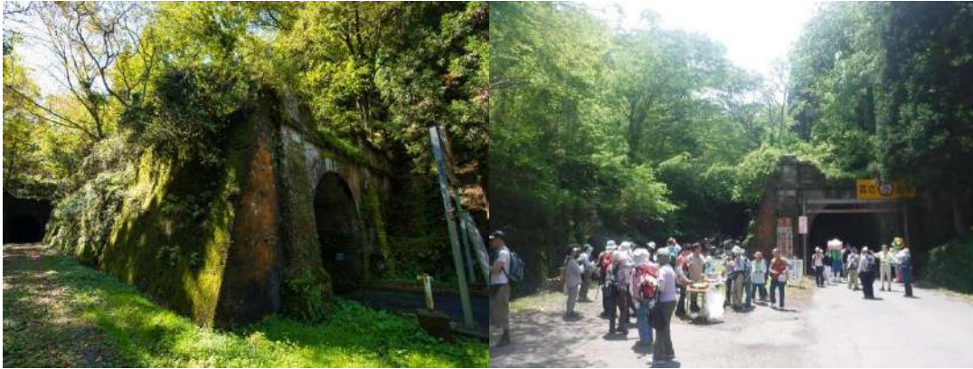
15 山中トンネル
