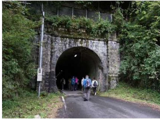
12 曲谷トンネル
