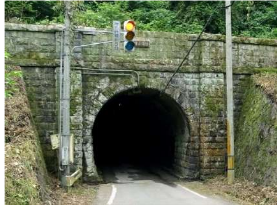
6 葉原トンネル
