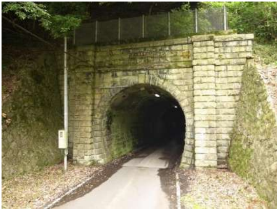
11 第二観音寺トンネル
