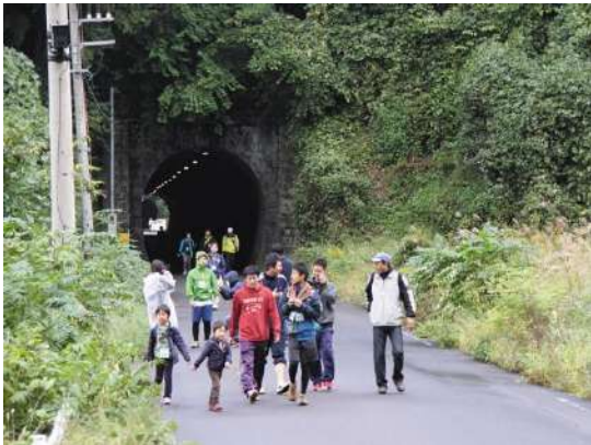
13 芦谷トンネル
