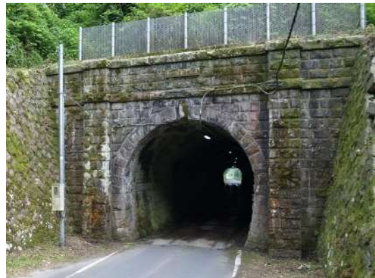
10 第一観音寺トンネル
