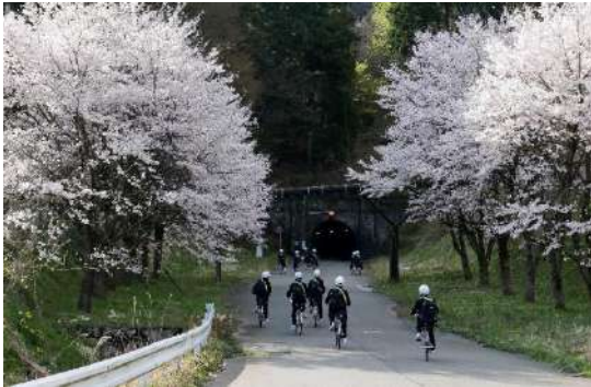
20 湯尾トンネル
