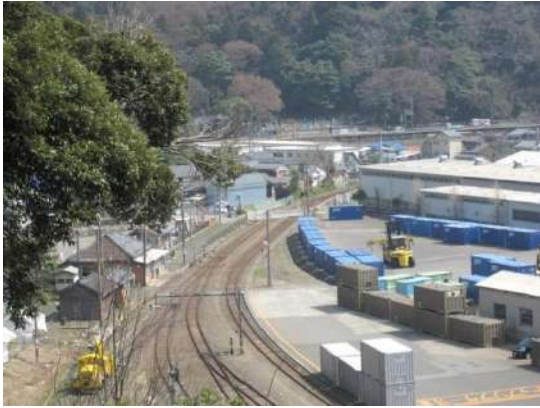
43 旧敦賀港駅線路
