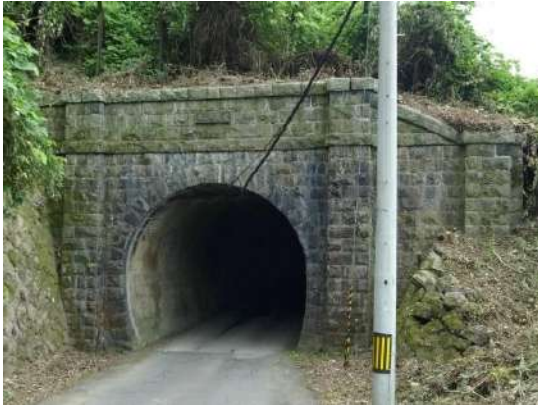
7 鮎ヶ谷トンネル
