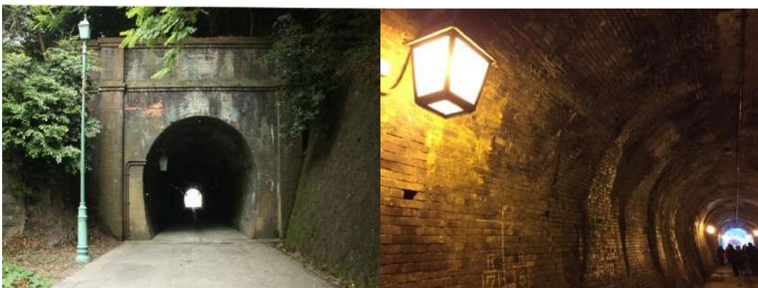
4 檜曲トンネル
