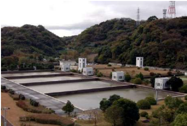
1-14a へみ 逸見浄水場
