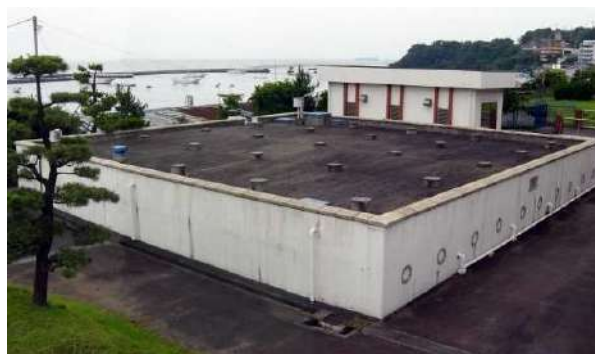
1-13b 走水水源地 鉄筋コンクリート造 浄水池
