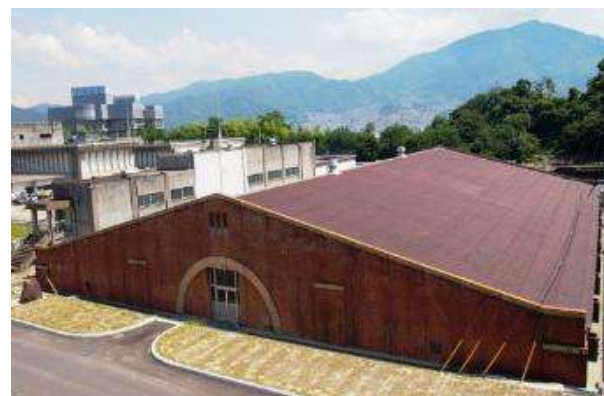
2-6 呉市水道局宮原浄水場低区配水池
