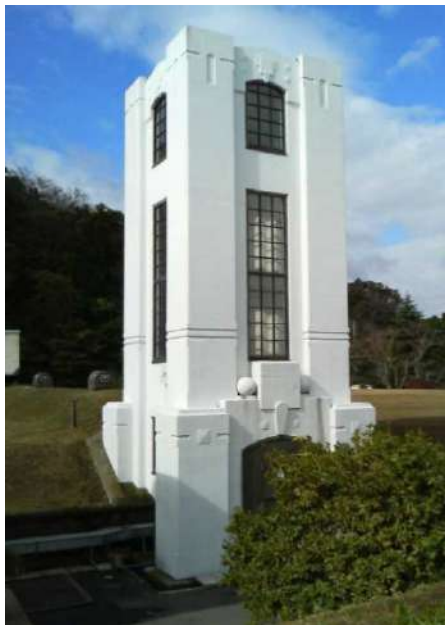
1-14b へみ 逸見浄水場 配水池入口
