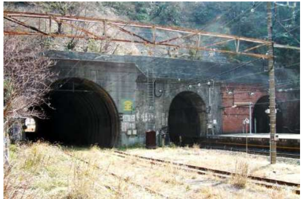
1-15 しつかま 七釜トンネル
