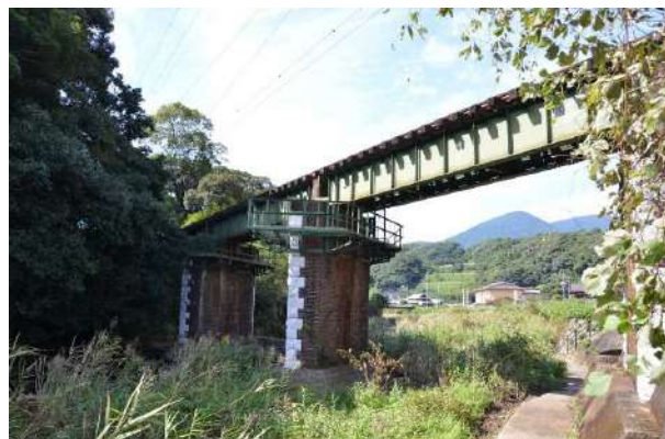
3-16 清水の瀬橋梁
