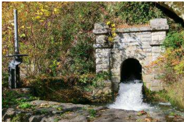
2-4 呉市水道局二河水源地取入口
