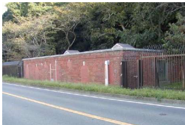
1-13a 走水水源地 煉瓦造貯水池
