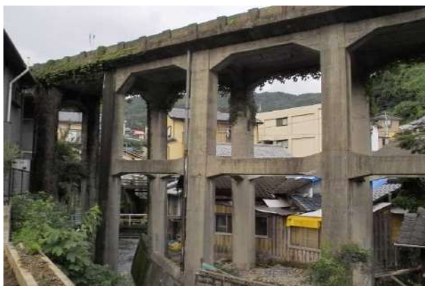
3-21 松浦鉄道(株)鉄道施設群(花園町橋梁)
