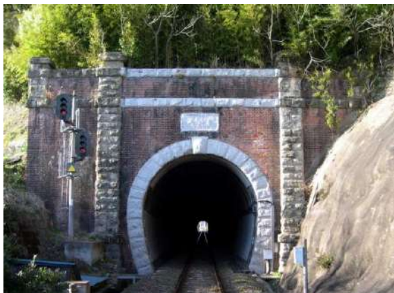
3-15 南風崎トンネル
