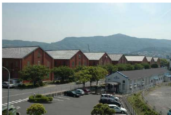
3-12 平瀬煉瓦倉庫群
