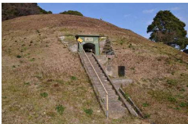
3-9 赤崎貯油所旧地下重油槽
