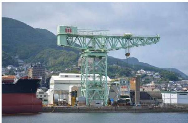
3-7 佐世保重工業(株)250トンクレーン
