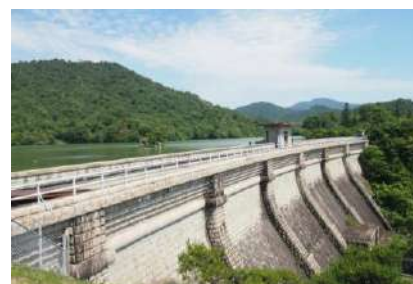
呉市本庄水源地堰堤水道施設 1920 年
