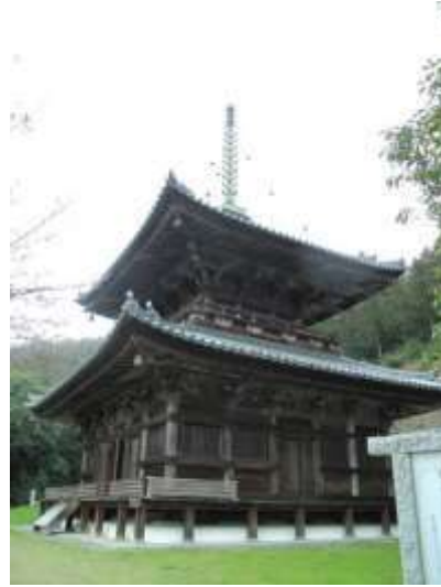
⑩切幡寺大塔
