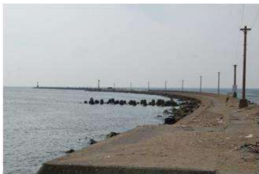
25-⑦ 三国港（旧阪井港）突堤
