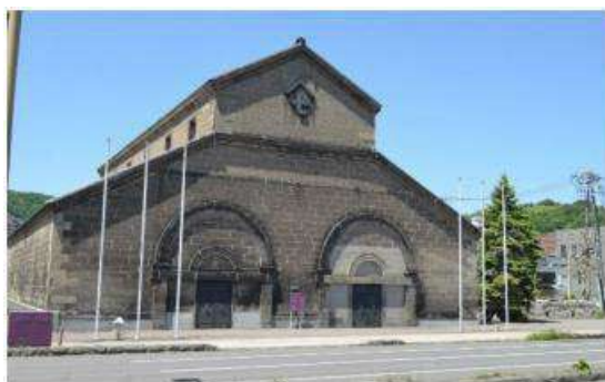
12-② 旧北浜地区倉庫群 (旧大家倉庫ほか)
