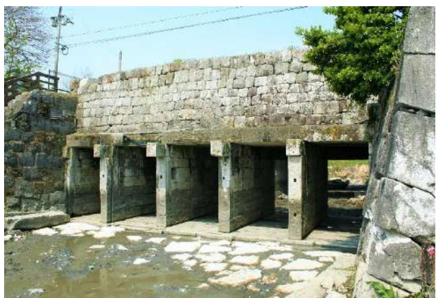
7. 大鞘樋門群(殻樋)
