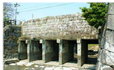
石工たちが築いた「大鞆樋門（穀樋）」
