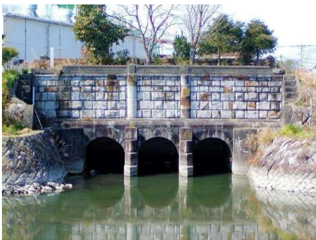
12. 郡築二番町樋門(正面)
