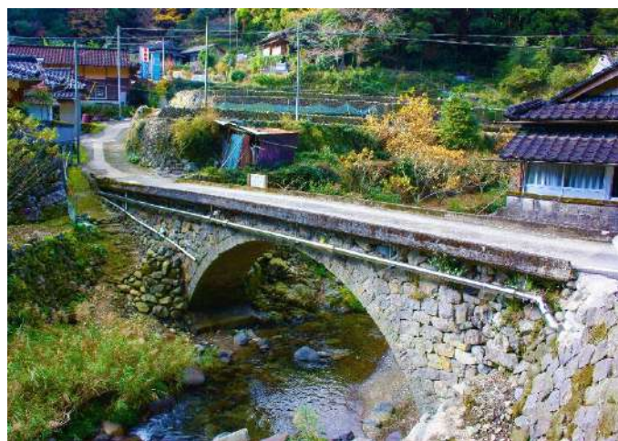
19. めがね橋群(蓼原橋)
