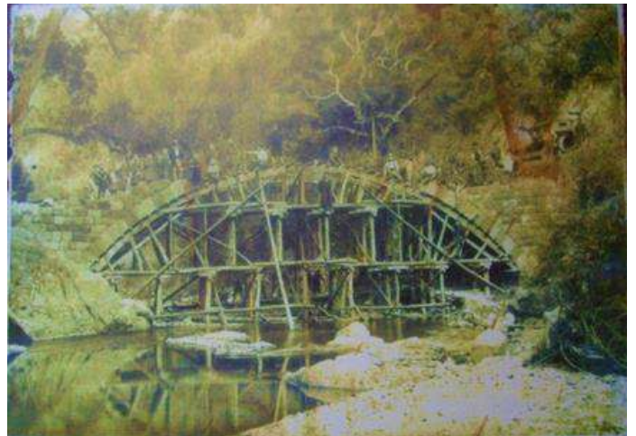
17. 谷川橋(架橋当時の写真)
