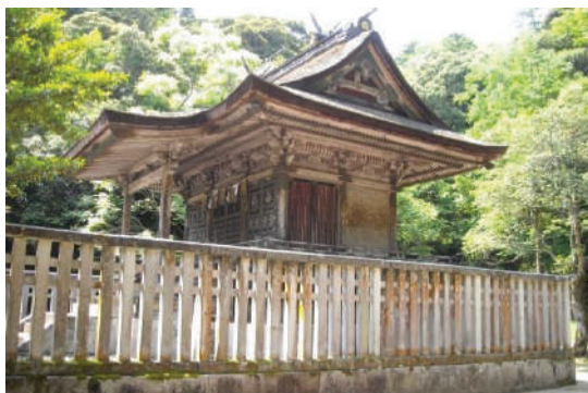
おうちだにじんじや ほんでん からもん はいでんおよ へいでん ②⑦ 檮谿神社 本殿、唐門、拝殿及び幣殿
