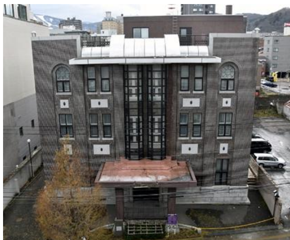
⑰ 繁栄期の料亭・ホテル建築群
