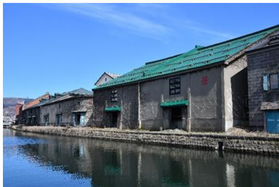
⑳ 運河完成後の倉庫群
