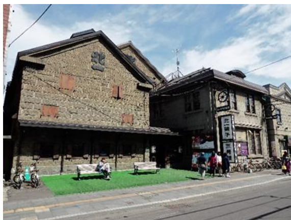
⑧ 南浜地区倉庫群
